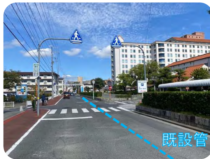
R 5 工事予定 倉敷中央病院(西側)
