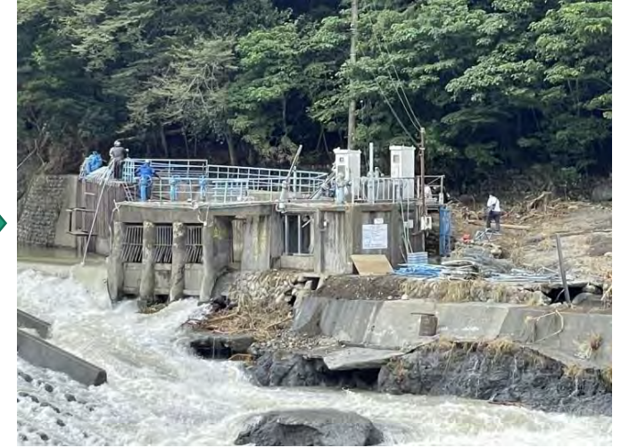
堆積物の撤去完了
