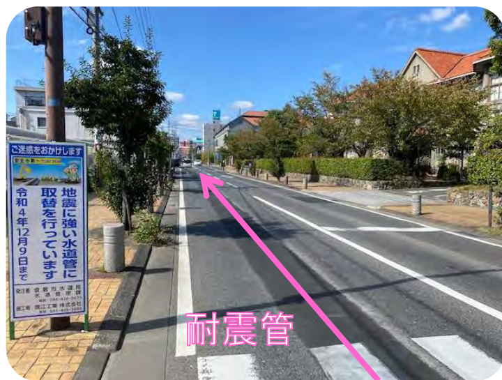
R 4 工事実施 倉敷中央病院(南側)
