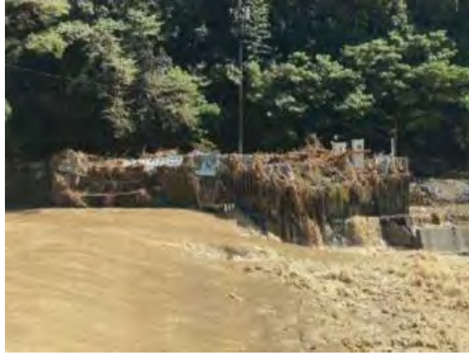
承元寺取水口に堆積した土砂や流木
