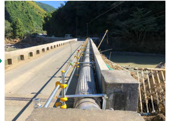
仮設管設置状況
