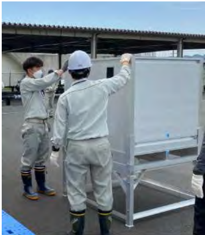
給水タンクを組立てる様子
