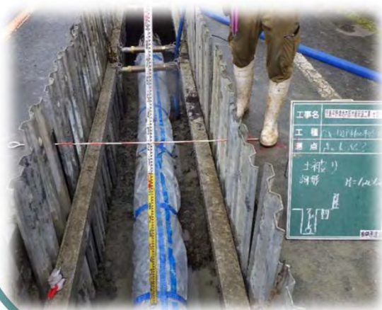
基幹管路布設状況
