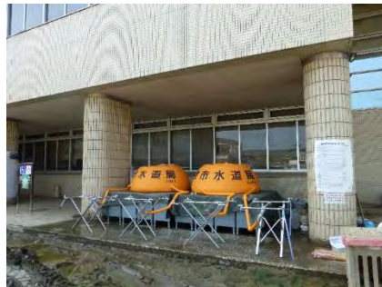
真備支所に設置した 臨時給水所
