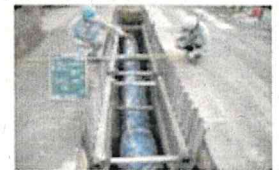
管路の更新工事
