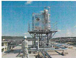
高置水槽を点検している様子（東中学校）
