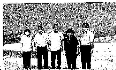
真備町末政川の決壊修繕場所
