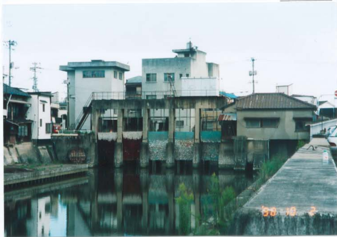
旧港橋水門（葦屋敷風水門から望見） 〔97ページ分布図⑦〕
