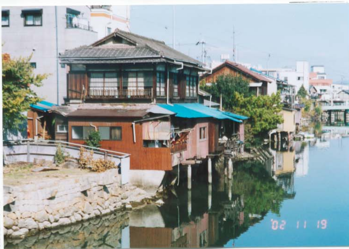
写真下……溜川にせり出した新地町の家並み。 家の表は道路に面した地上に、 家の半分以上裏手は水上にせり出して、水中の支柱に支えられている。 新地町に限らず、港の周辺では狭い土手の有効利用の生活の智慧が随所に見られる。
