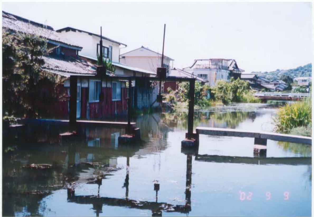
背戸川水門跡 「97ページ分布図④」 鉄製の水門柱が昔日の姿をわづかにとどめる
