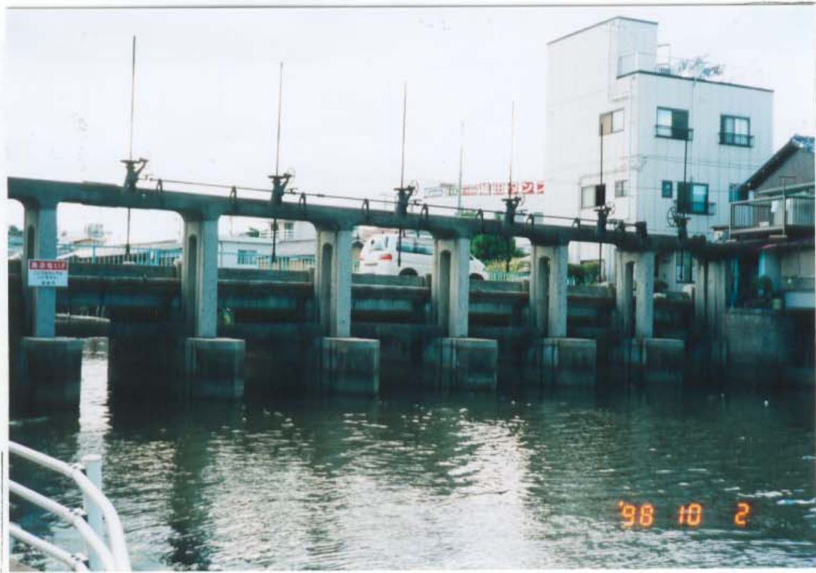
旧新橋水門（内側）
