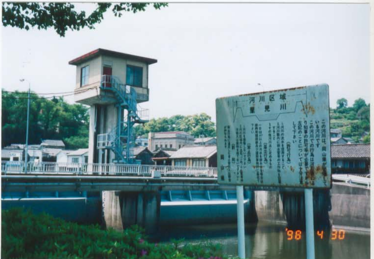
写真下は水谷侯遺徳顕彰碑付近から見た昭和水門
