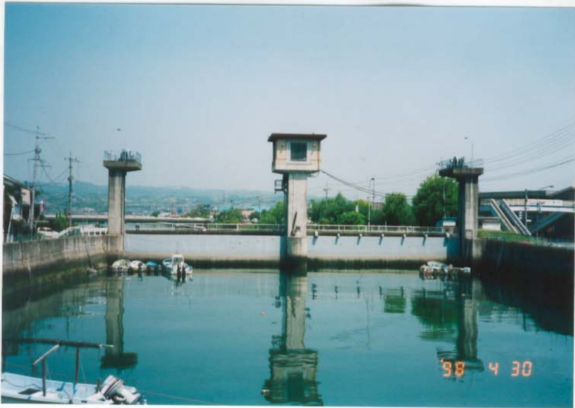
写真上は昭和橋より北方に望む昭和水門
