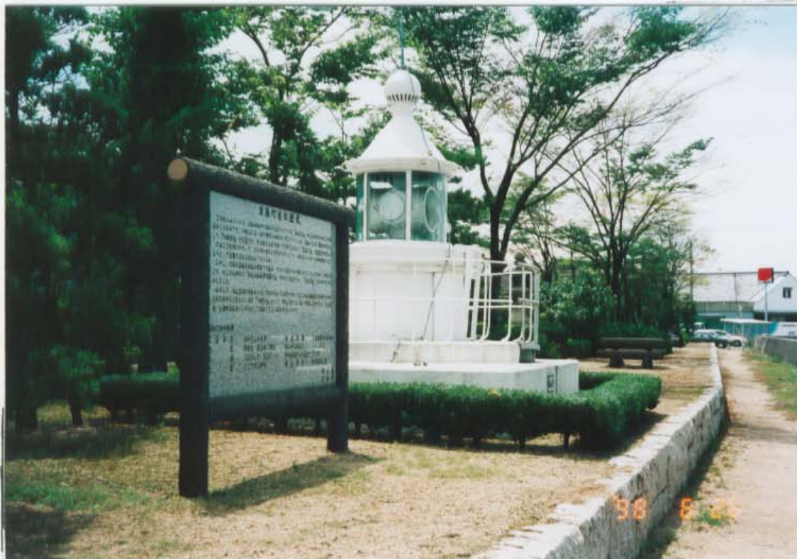
玉島灯台記念建造物（写真上）と「玉島灯台の歴史」案内説明板（写真下）
