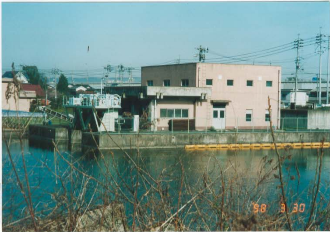
写真上は八島排水機場全景を西南方向から見たもので、ポンプアツプによ
