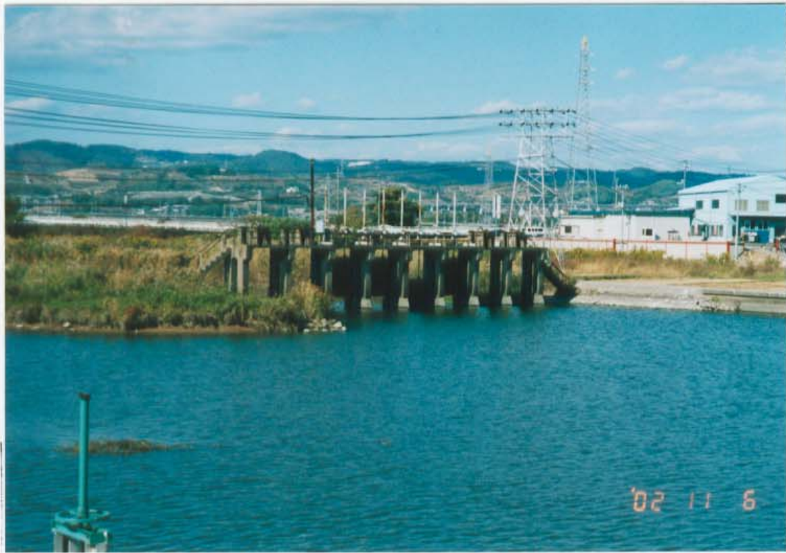
写真上は八丁洲樋門 (P11の写真も参照)
