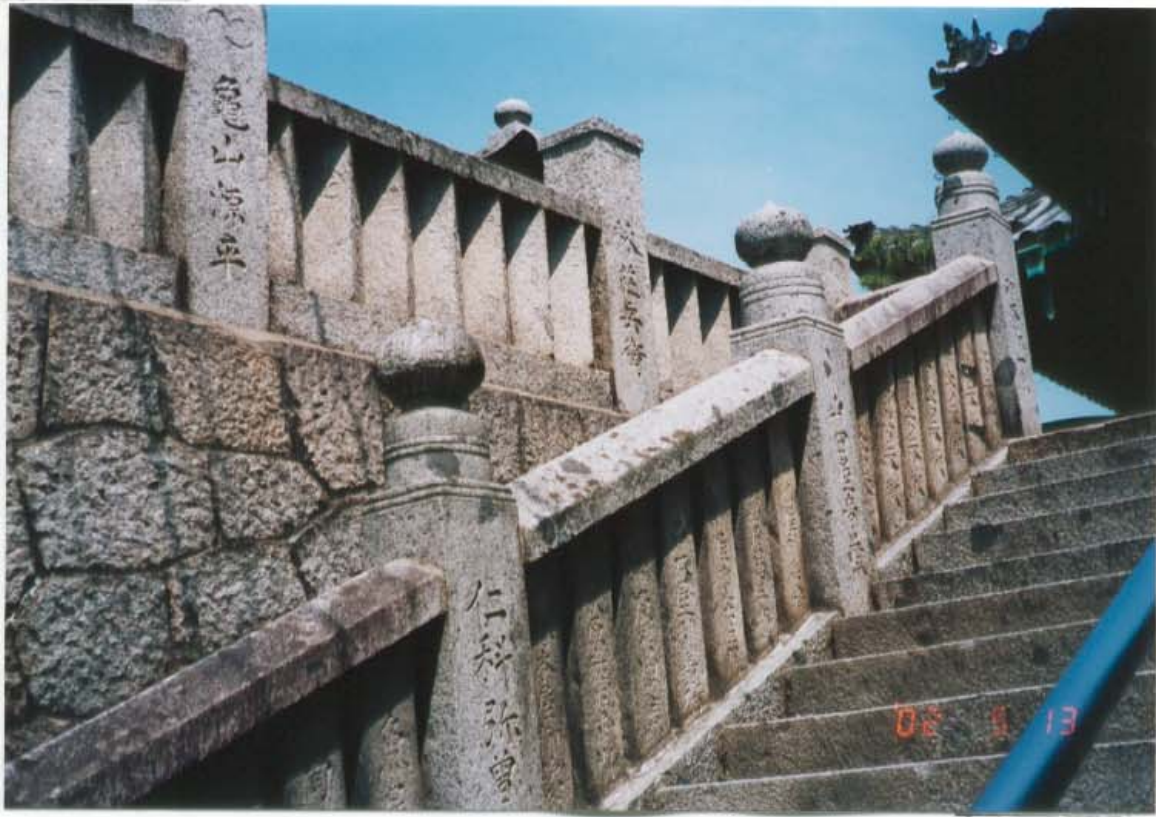
正面参道の最上段西側玉垣の一部 と石垣上に沿った境内外周の玉垣
