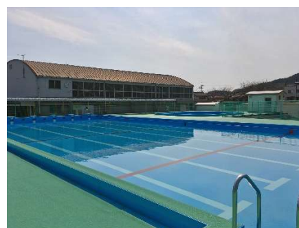
プール槽 改修後
