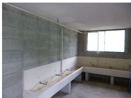
目洗い場 改修前
