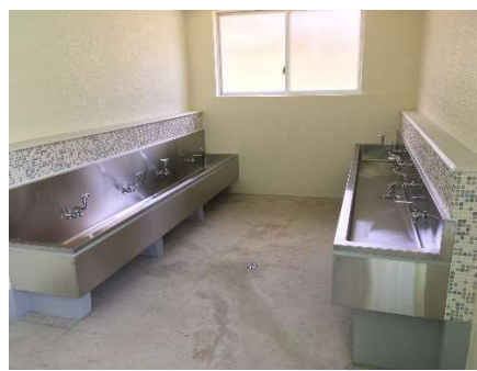
目洗い場 改修後
