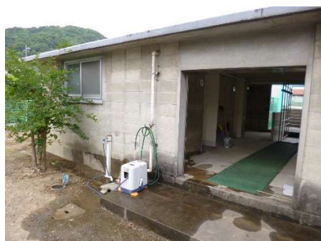
プールハウス 改修前
