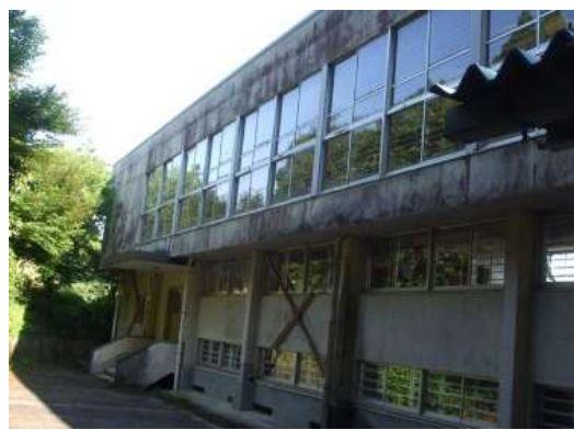
構造躯体以外の劣化状況調査 (仕上, 設備等)
