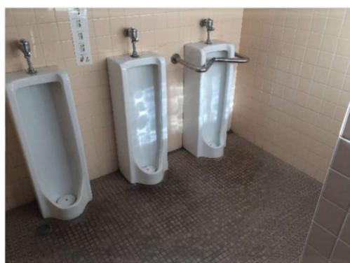
トイレ改修前
