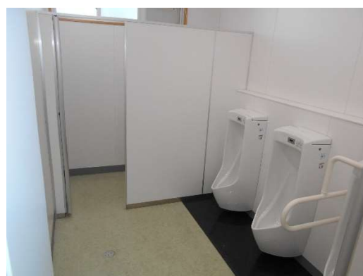
トイレ改修後
