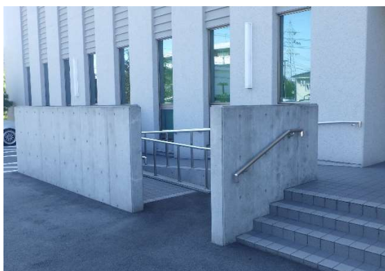
スロープや手摺を設置
