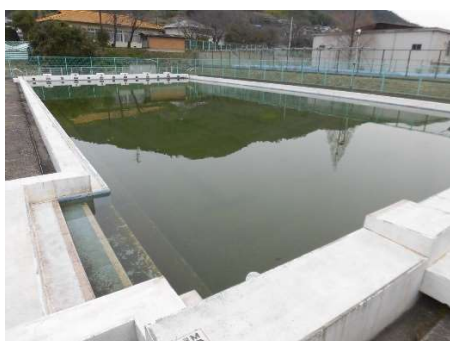
プール槽 改修前
