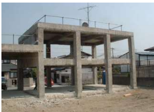
構造躯体の健全性調査
