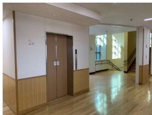
エレベーター設備
