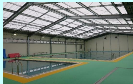
完成した箭田小学校上屋付きプール
