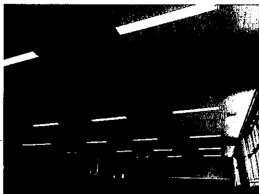
高効率なLED 照明
