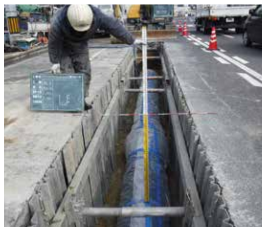
地震に強い水道管に入れ替えています
