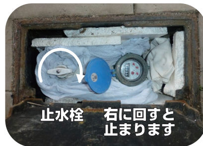
▲メーターボックス内の止水栓の閉め方
