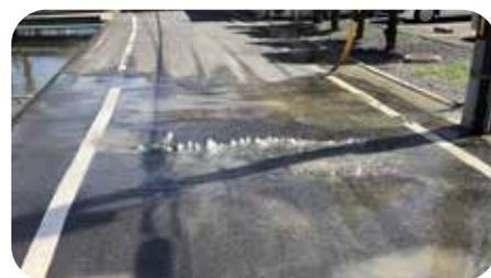
▲古くなった水道管からの漏水が路面に吹き上がっている様子
