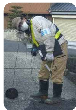
▲漏水調査の様子
