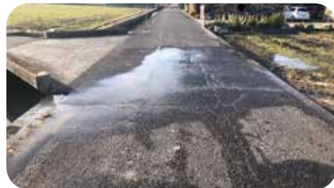
▲雨が降っていないのに漏水で路面が濡れている様子
