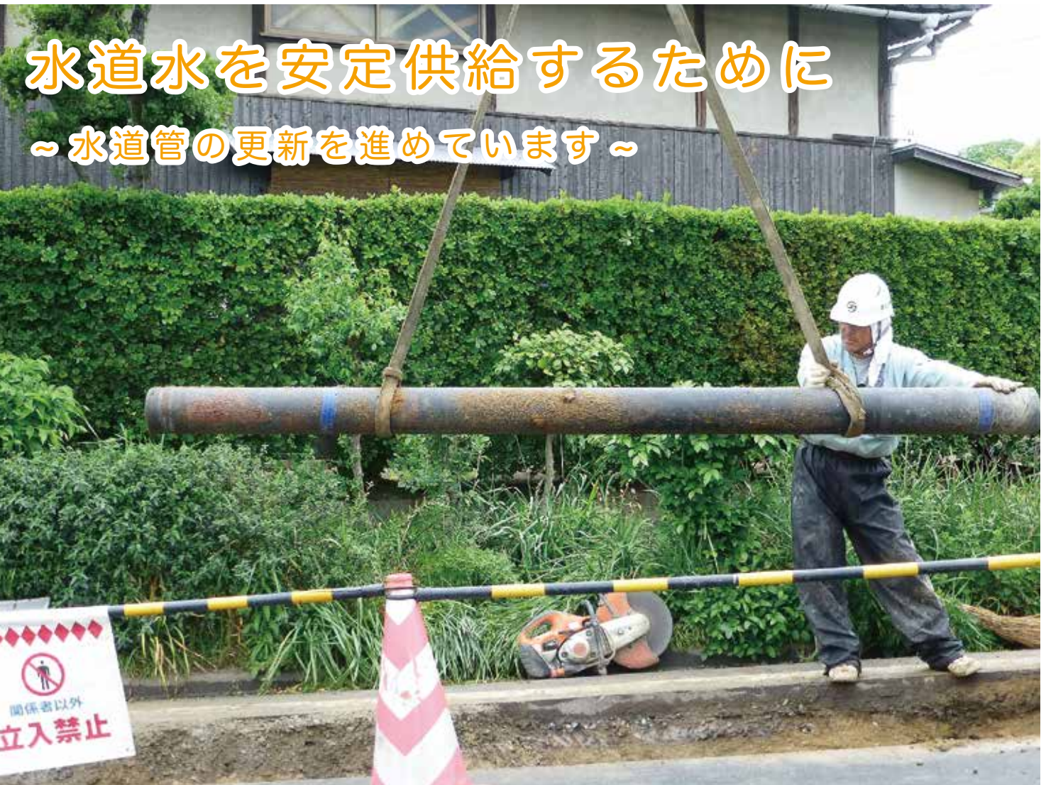
▲古い水道管の撤去の様子
