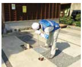
▲漏水調査の様子
