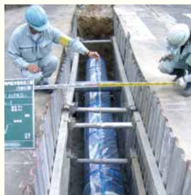
水道管の工事
