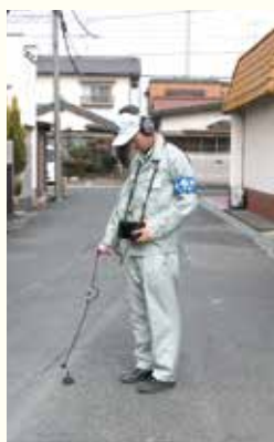
道路での漏水調査
