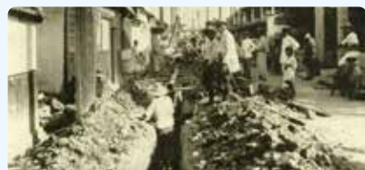
倉敷町内での水道管敷設の様子
