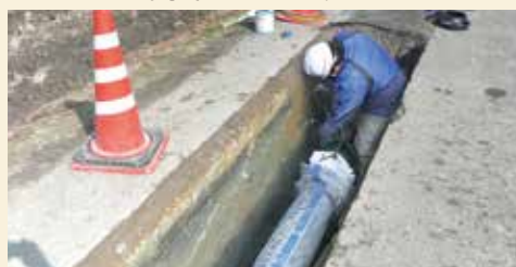
▲水道工事の様子
