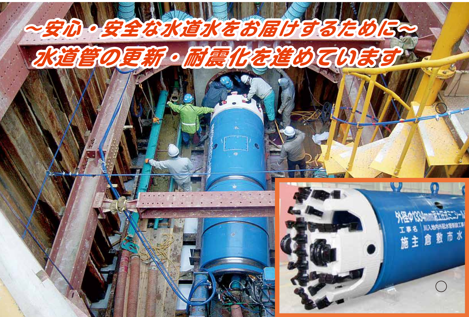
▲シールド掘進機設置の様子。写真上に向かって掘り進みます。
