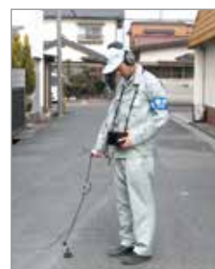
▲漏水調査の様子
