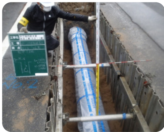
▲地震に強い水道管に入れ替える工事を行っています▲
