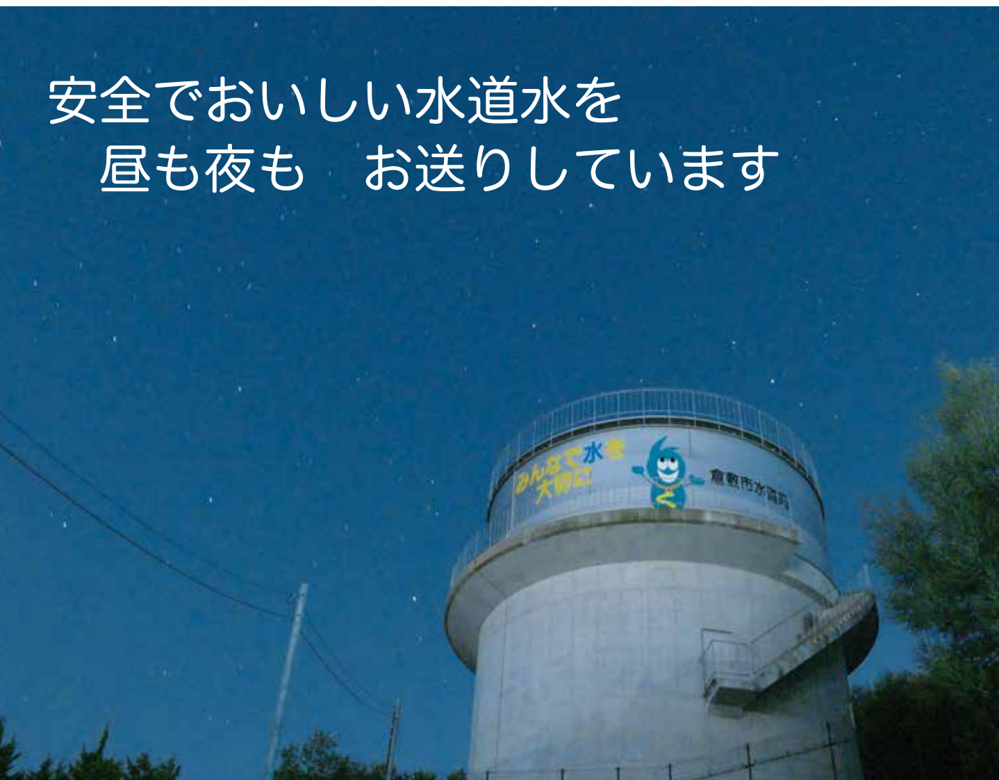
▲西坂台団地高架水槽
