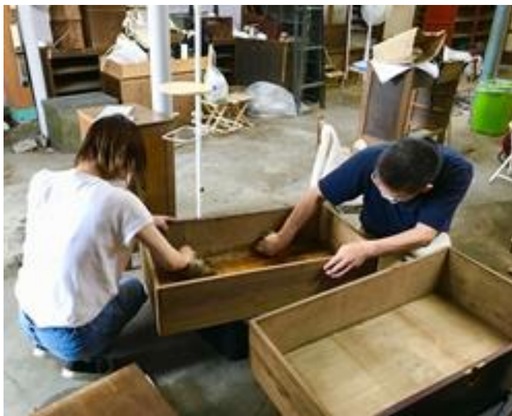
▲ 空き店舗改修のお手伝い
