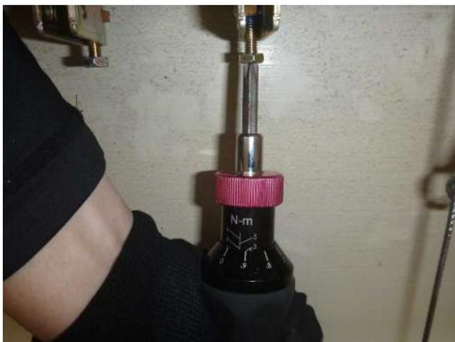
施工説明書記載の締め付けトルクになっていることがわかるように写真を撮影する
