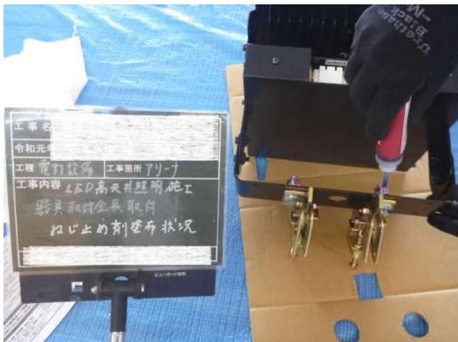
ボルト締め付け前に、ねじ部に緩み止め剤を塗布する
