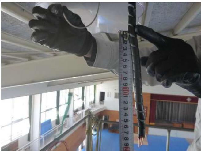
取付ボルト脱落時、ケーブルに荷がかからないことがわかるように写真を撮影する
