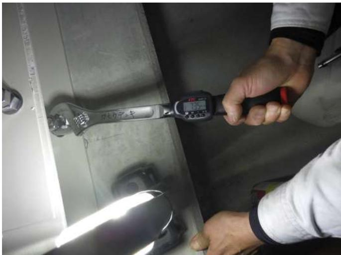
使用するボルトサイズの推奨トルク値で締め付けていることがわかるように写真を撮影する
