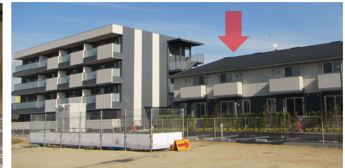
リビングタウン石見町 外観
