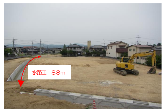
② 寿町石見線沿いの水路工事及び宅地造成工事
