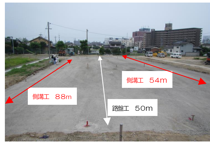
① 寿町八王寺線の側溝及び路盤工事
