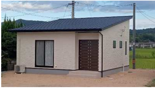
【地域集会所の復旧状況】 令和5年度 新築(箭田地区)
