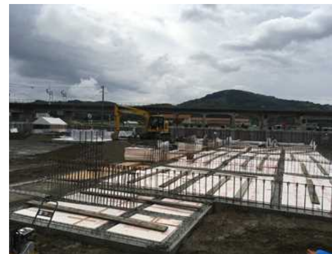
【箭田南団地 基礎工事施工状況】
