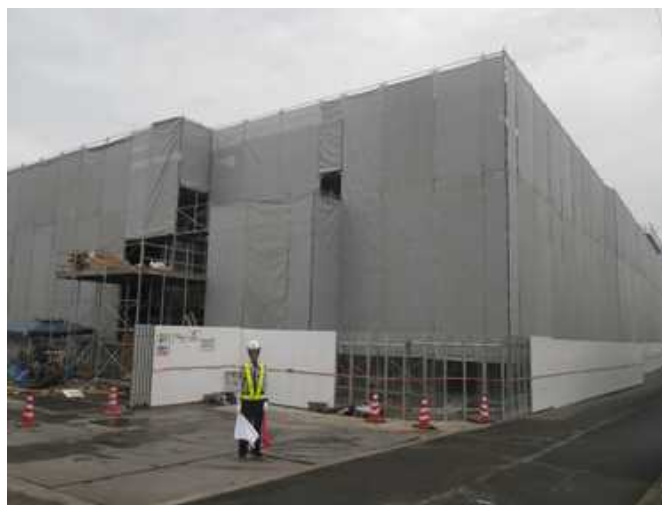
【川辺団地 3階部分施工状況】
