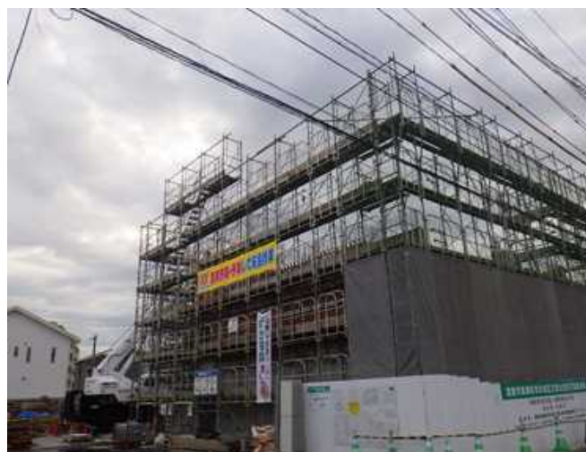
【有井団地 2階部分施工状況】
