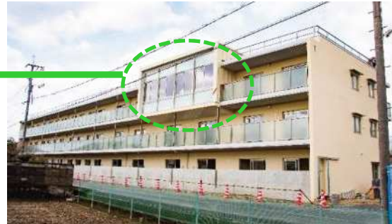
集会室外観（川辺団地）
