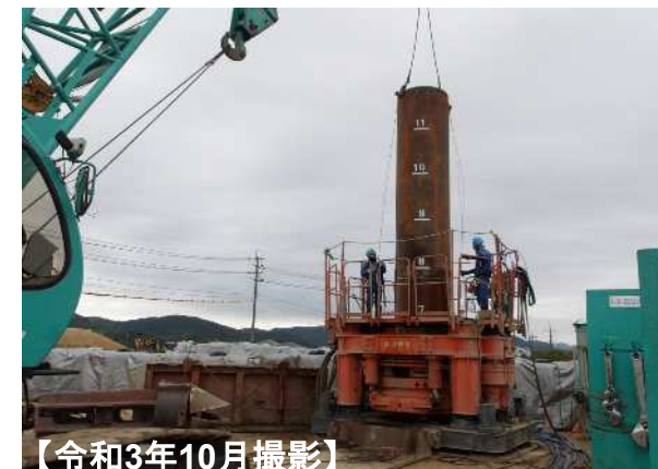
場所打杭工施工状況(有井橋左岸)
