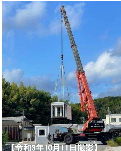
建設型仮設住宅の撤去状況(柳井原)
