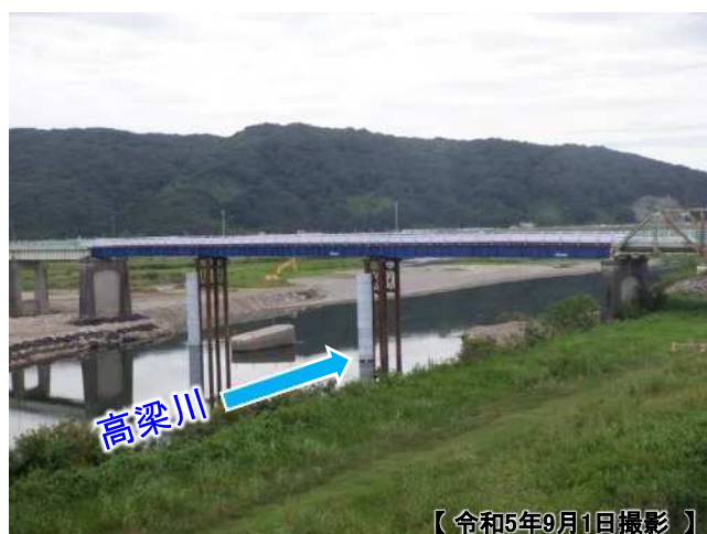
川辺橋（歩行者・自転車用側道橋）の仮橋設置状況 （延長 8.5 m、幅 3 m、橋脚 2 基）
