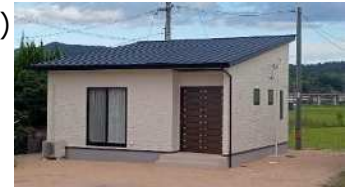
【地域集会所の復旧状況】 令和5年度 新築（箭田地区）
