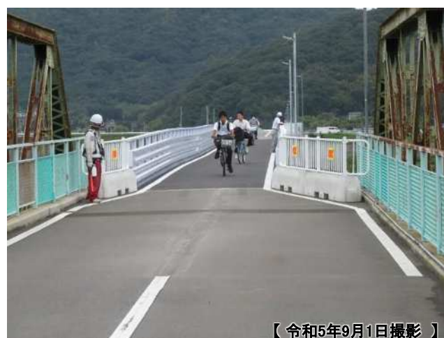
川辺橋（歩行者・自転車用側道橋）の仮橋設置状況 （延長 8.5 m、幅 3 m、橋脚 2 基）
