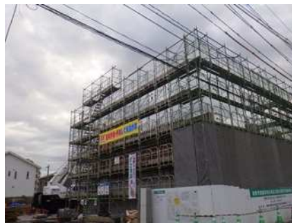
【有井団地 2階部分施工状況】
