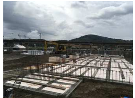
【箭田南団地 基礎工事施工状況】
