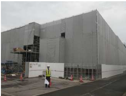
【川辺団地 3階部分施工状況】
