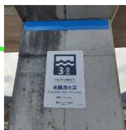
実績浸水深標識
