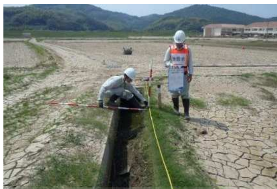
【土砂が堆積した水田】
