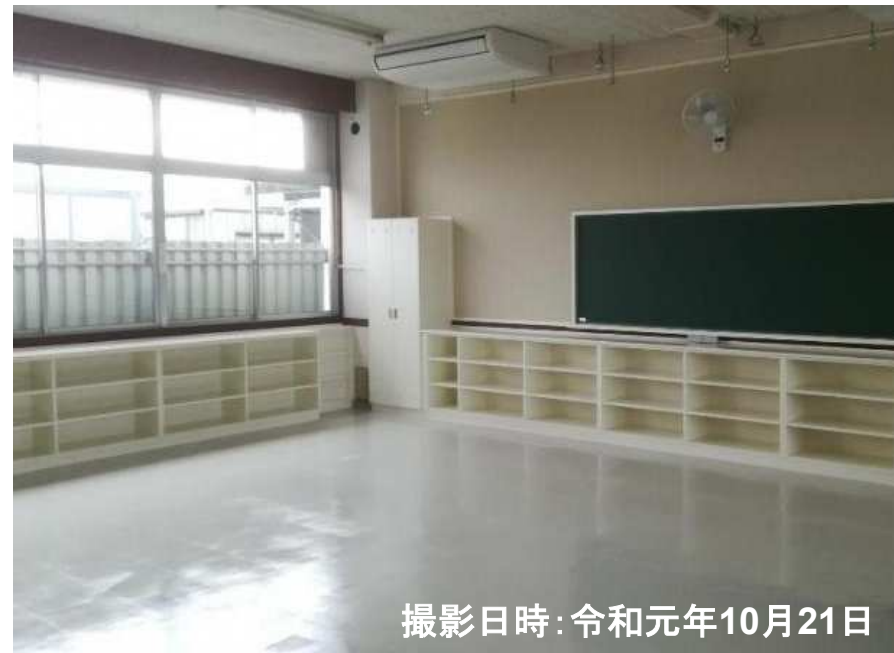
復旧が完了した教室
