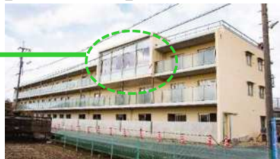
集会室外観（川辺団地）
