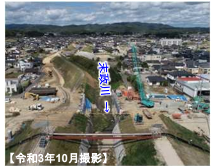
場所打杭工施工状況(有井橋左岸)
