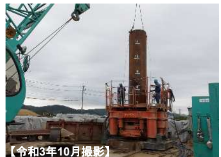
場所打杭工施工状況(有井橋左岸)
