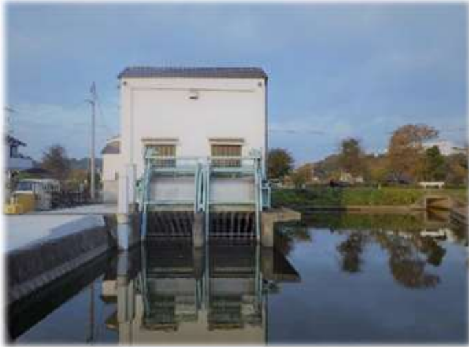
粒浦排水機場 市内各地には大小様々な多数の農業用施設 が設置されています
