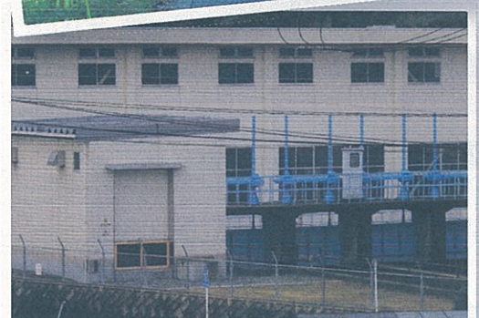
9 笠岡共用導水路船穂揚水機場
