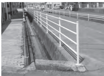
▲転落防止柵を設置
