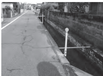
▲視線誘導標を設置
