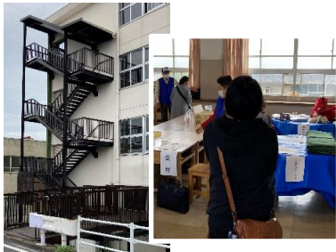
乙島東小学校に設置された外付け階段。
