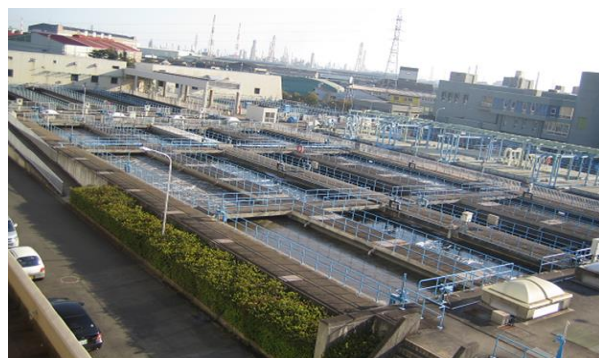
高度処理を導入している水島下水処理場の水処理施設
