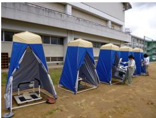
マンホールトイレ (緊急トイレ)
