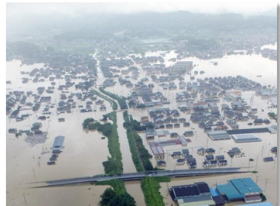
浸水した真備町の様子
