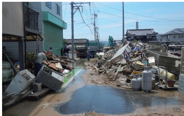
作業スペース確保のための仮置き
