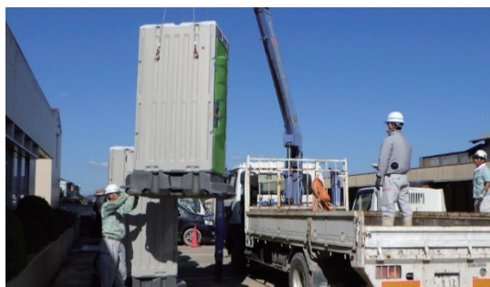
仮設トイレ設置状況
