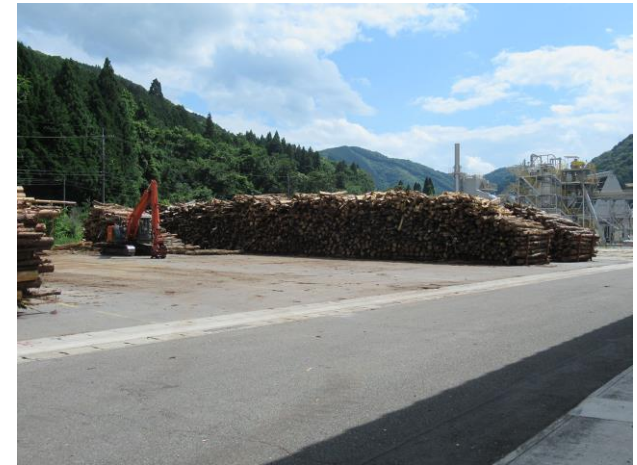
新見バイオマス発電所
