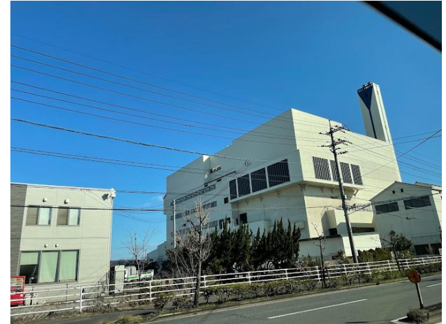
水島清掃工場
