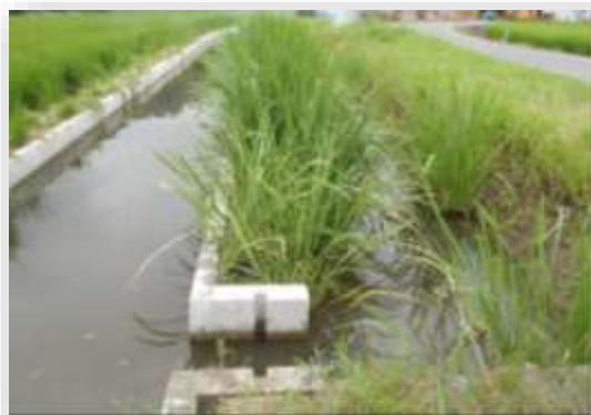
自然環境に配慮した用水路施工事例
