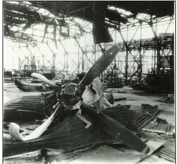
【空襲後の航空機のエンジン部分】
