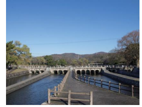
高梁川東西用水取配水施設
