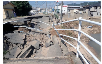
平成30年7月豪雨 道路損壊状況
